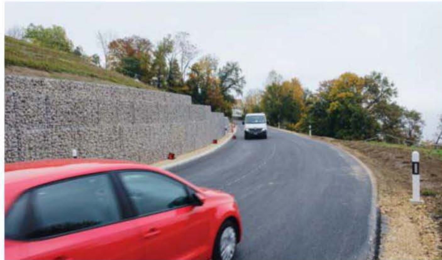
La route entre La Cézille et le village de Bassins a été remise en état et rendue à la circulation. CÉDRIC SANDOZ
